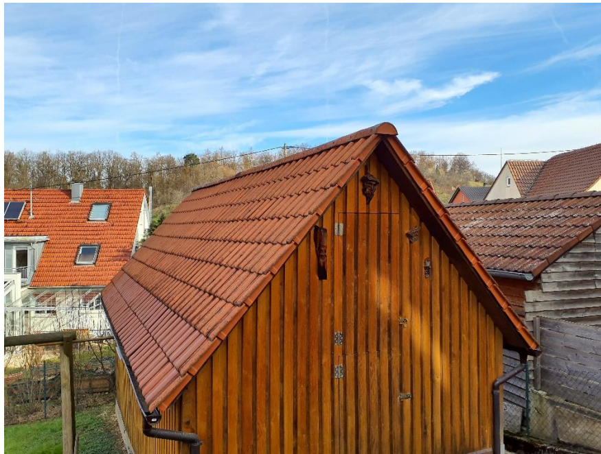
Bild 5: Auch am zweiten Bestandsgebäude existieren entsprechende Spaltenquartiere. A. RAICHLE, 17.03.2023
