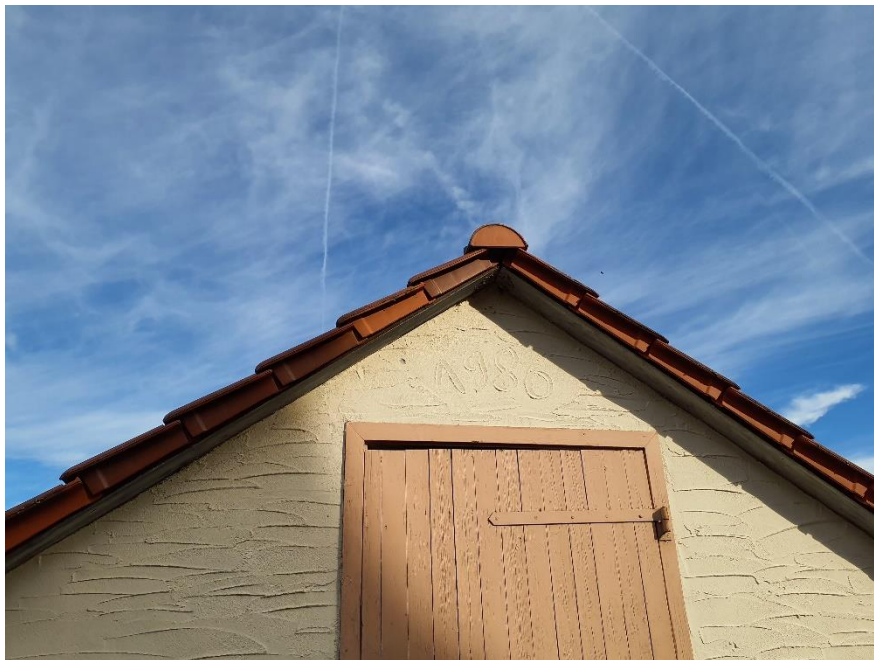
Bild 4: An den beiden Bestandsgebäuden existieren potentielle Spaltenquartiere die als Tages- einstand für Fledermäuse genutzt werden können.
