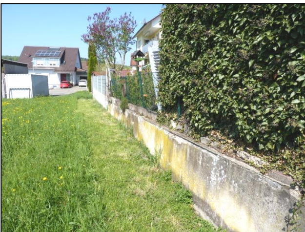
Abb. 11 Betonmauer an der nordwestlichen Grenze des Planungsgebietes.
