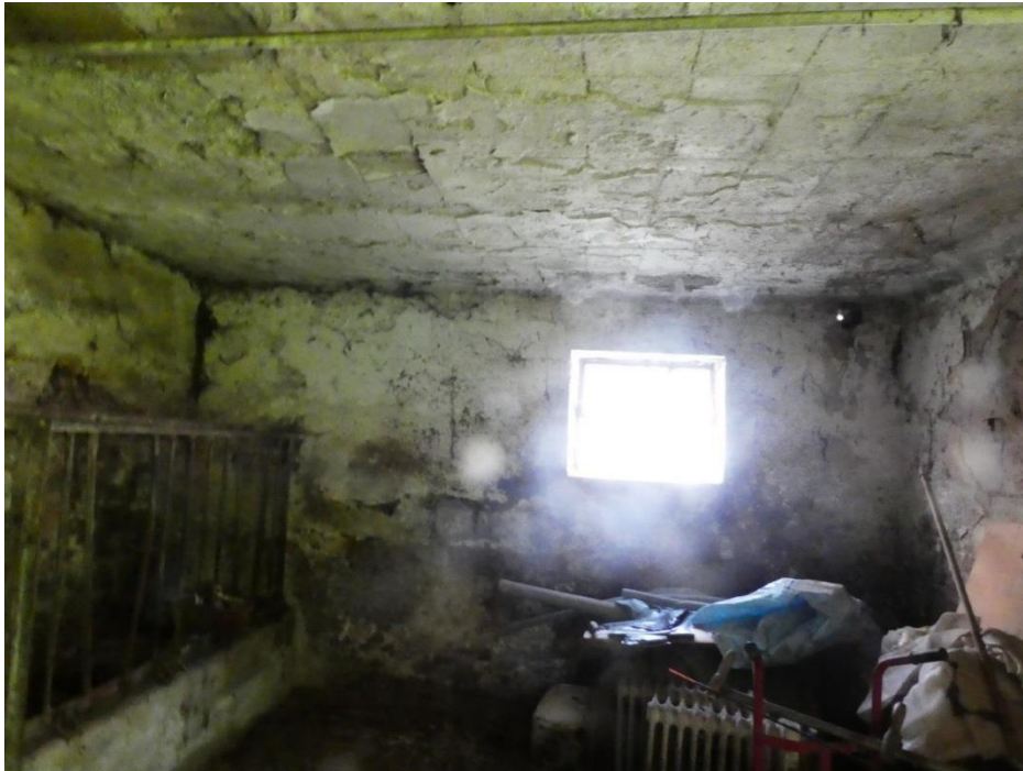
Abbildung 5: Ehem. Stallung /Scheune - Innenansicht
