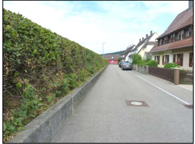
Abb. 4 Formhecke und Betonmauer im Grenzbe- reich zur Kantstraße.
