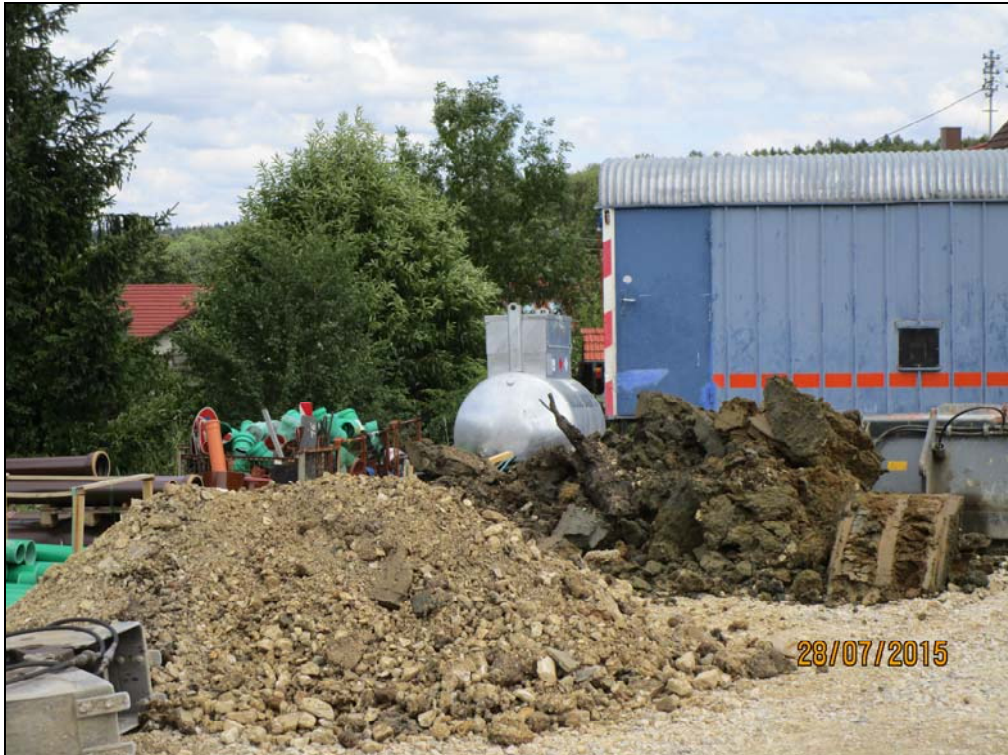
Bild 5: Material Schurf 1 (vorne links Auffüllung, hinten Boden)
