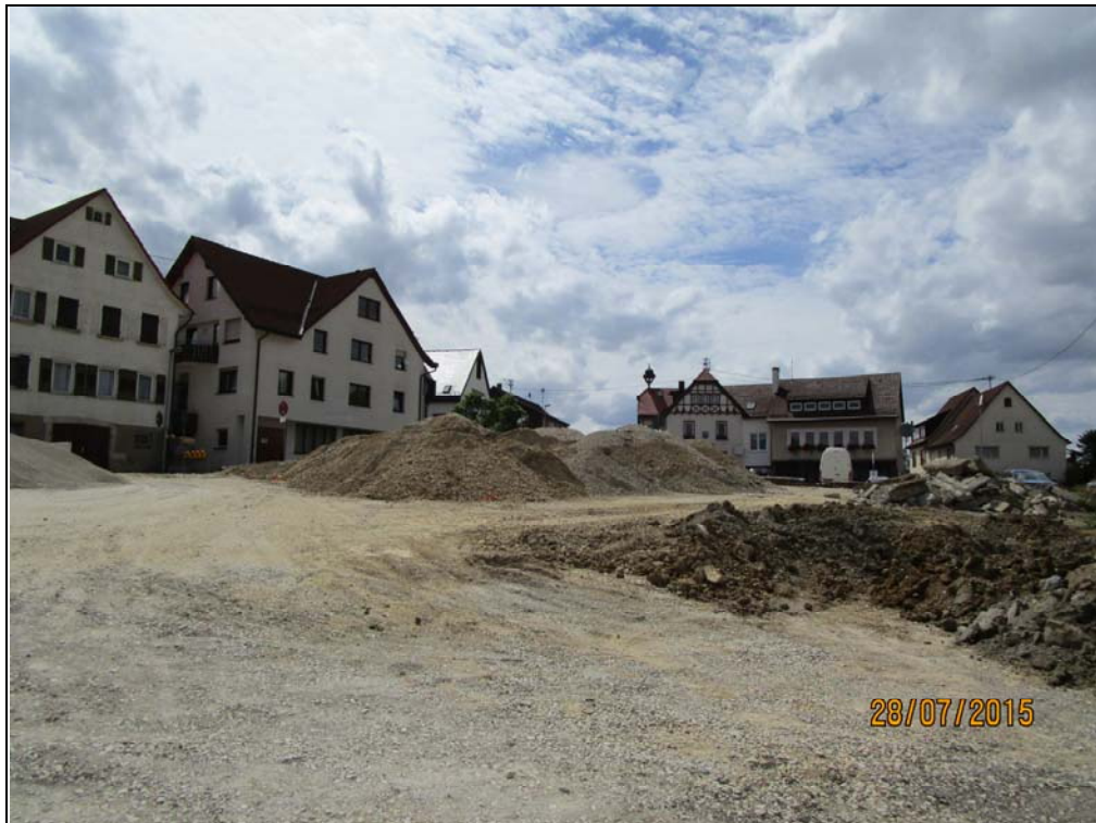
Bild 1: „Ganter-Areal“ Tischardt, Blick nach Westen
