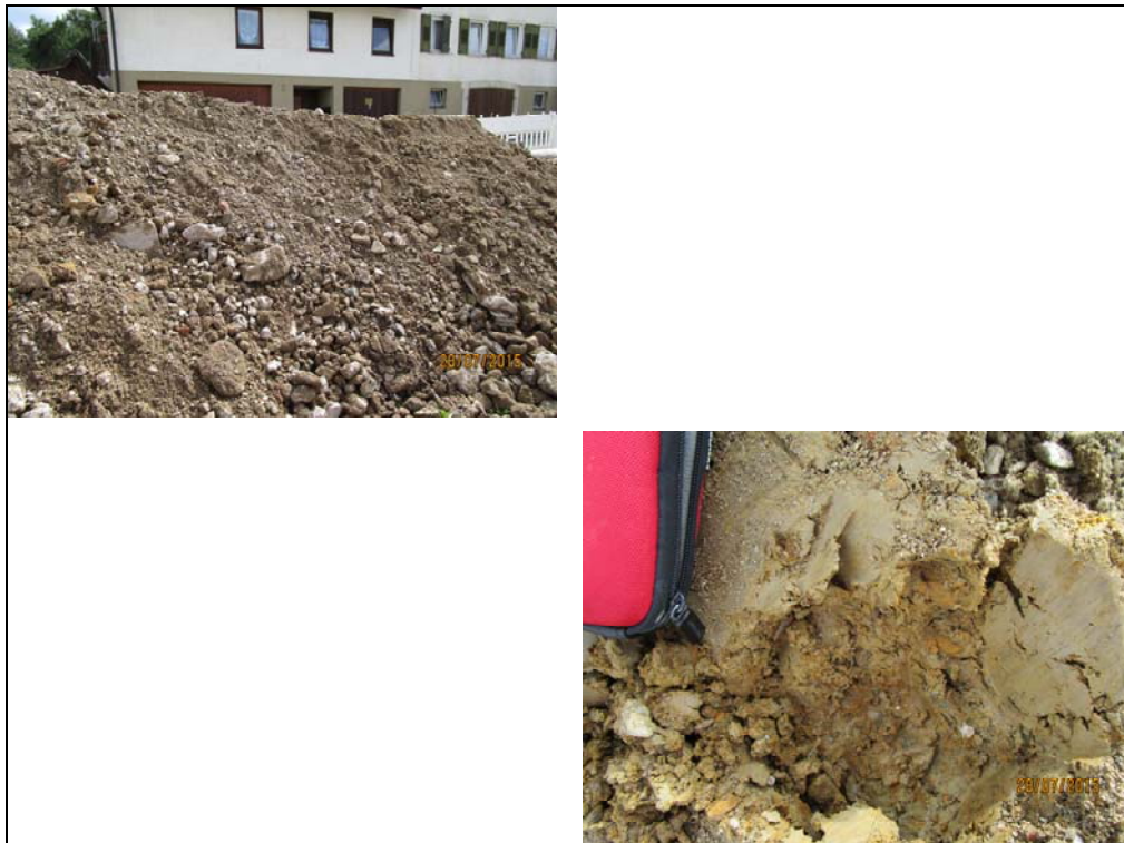
Bild 9: Material Schurf 3, Auffüllung(oben) und Boden (unten)
