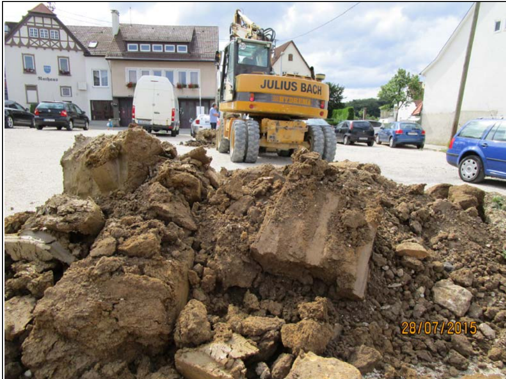
Bild 13: Schurf 5, Lehm Boden ab 0,4 m Tiefe.
