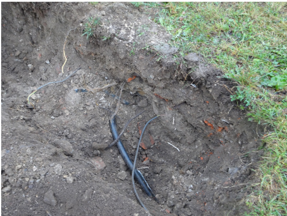
Bild 6: Alte Hartgummileitung (Wasserleitung?) in ca. 0,50 m Tiefe
