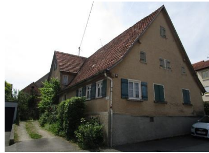
Mittlere Straße 1 Quelle: die STEG
