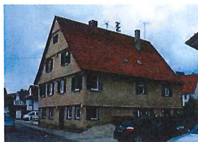
Obere Straße 6: Wohnhaus einer früheren Hofanlage, verputzter Fachwerkbau mit Vorstößen und Knaggen, 16. Jahrhundert sowie Trog mit gusseiserner Pumpe (derzeit eingelagert); 19. Jahrhundert. (Sachgesamtheit) Typisches, wenn auch im Bestand bedauerlicherweise reduziertes, jedoch vergleichsweise altes Dokument des Bauens und Wohnen im Ortskern.
