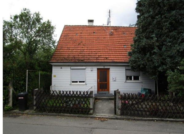
Substanzielle Mängel, Gartenstraße 19 Quelle: die STEG
