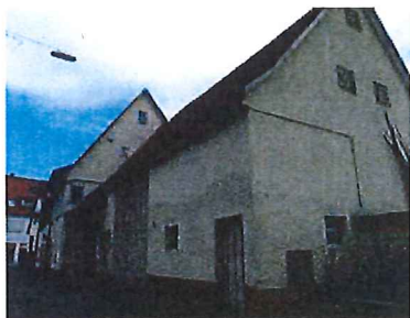
Hartliebstraße 3, 3/1 und 5: Verputztes Fachwerkhaus, im Kern 17./18. Jh., mit versetzt anschließender Ökonomie; typischer, wenn auch im Detail überformter Teil der dichten Ortsbebauung in Frickenhausen.
