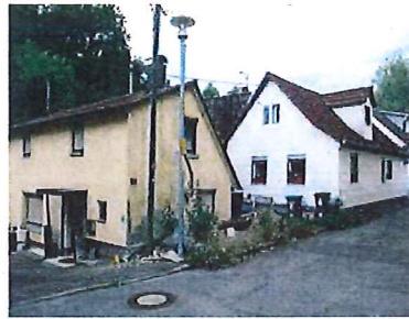
Bachstraße 8 und 10: Kleinsthäuser, 19. Jh., stark überformt, Hinweis auf die historische Sozialtopografie im alten Ortskern.
