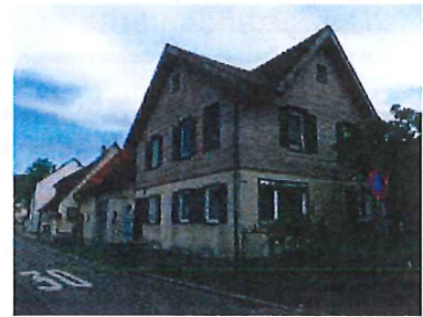
Ziegeleistraße 2: Verputztes Fachwerkhaus mit Zwerchgiebel, 19. Jh., mit direkt anschließender Ökonomie; typischer, wenn auch im Detail überformter Teil der traufständigen Bebauung am ehem. Ortsrand.
