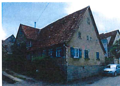
Mittlere Straße 1: Wohnhaus, verputzter Fachwerkbau mit anschließendem Brennhaus und Pumpe mit Trog, 18. Jahrhundert, mit neuem Zwerchhaus, gusseiserner Ofen von 1759 (Sachgesamtheit) Typisches Dokument des Bauens und Wohnen im Ortskern und wichtiger Teil der historischen Reihe giebelständiger Gebäude in der Mittleren Straße.
