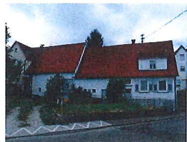
Im Dorf 6, 6/1: Verputztes Fachwerkhaus, 19. Jh., mit direkt anschließender Ökonomie; typischer, wenn auch im Detail überformter Teil der dichten Ortsbebauung in Frickenhausen.
